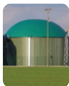
Transformação em Biogás
