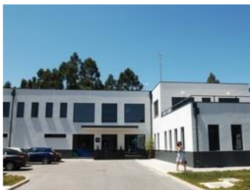
Figura 35. Estação de Tratamento de Água (ETA)
